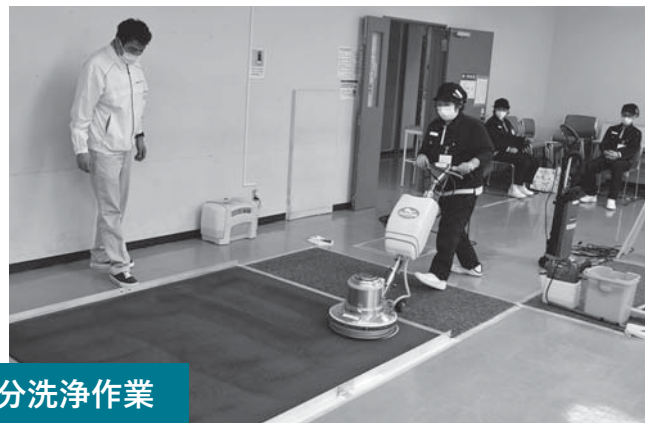
1級弾性床表面洗浄作業
