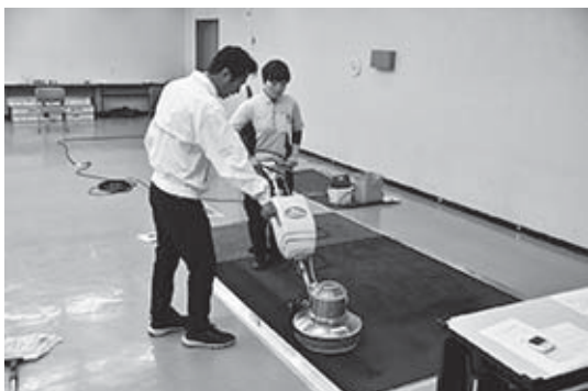
1級 繊維系床部分 洗浄作業
